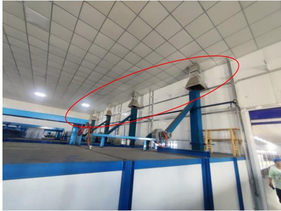
烤花炉有机废气集气罩
