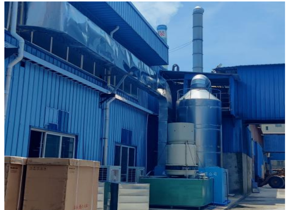
有机废气处理站装置及其排气筒
