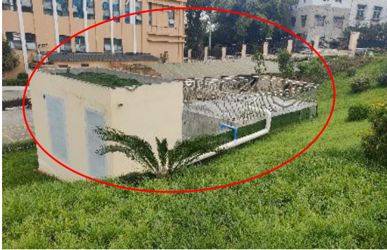
污水处理站及站房
